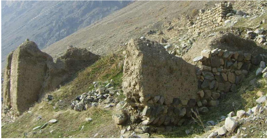
Şəkil 2. Ordubad rayonu, Köhnə Kotam kəndi. Yaşayış yerinin möhrə divarının qalıqları 2. Təbii daş materiallarından ibarət olan divar qalıqları.
